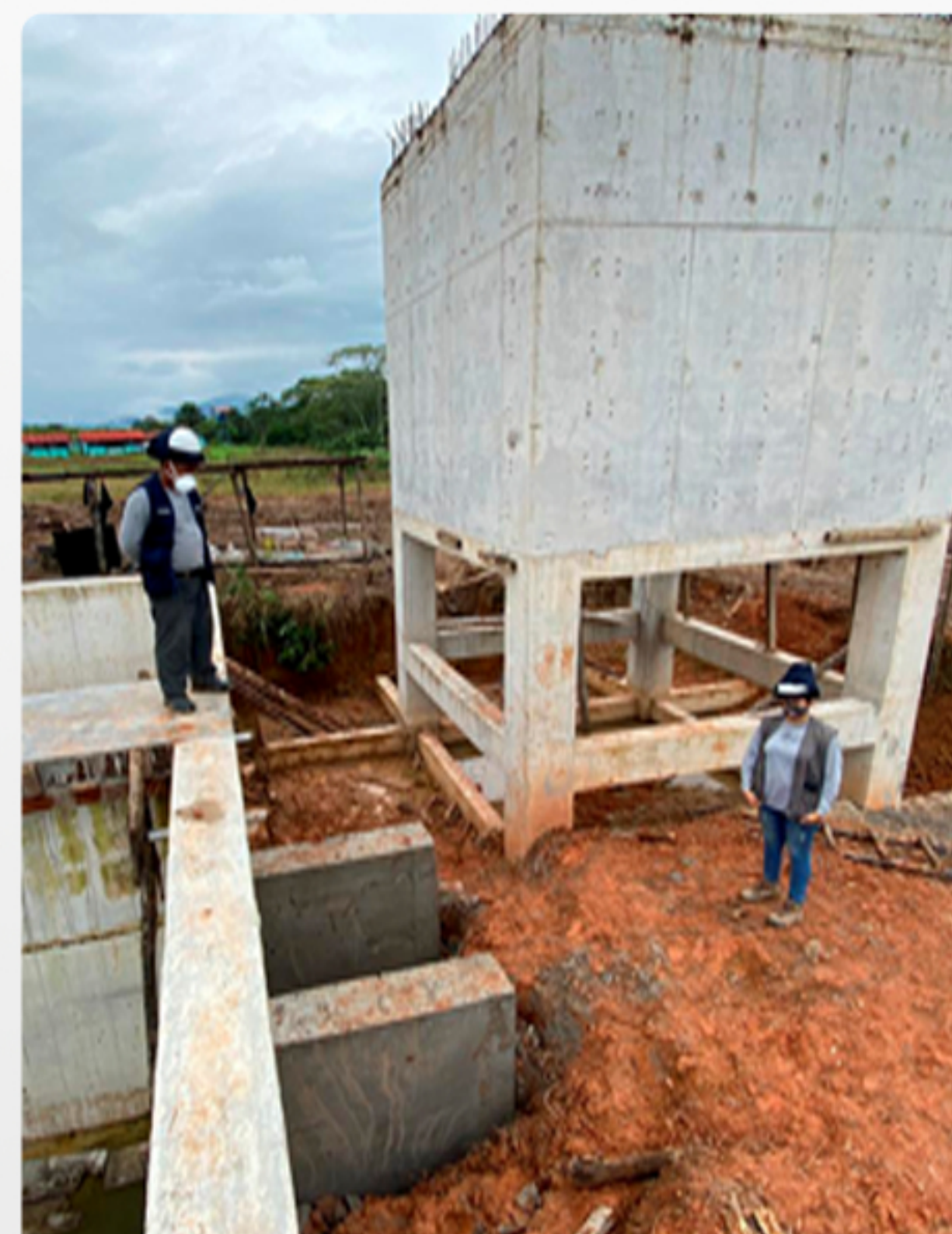
ESTRUCTURAS DE CONCRETO ARMADO DE FILTRO LENTO
