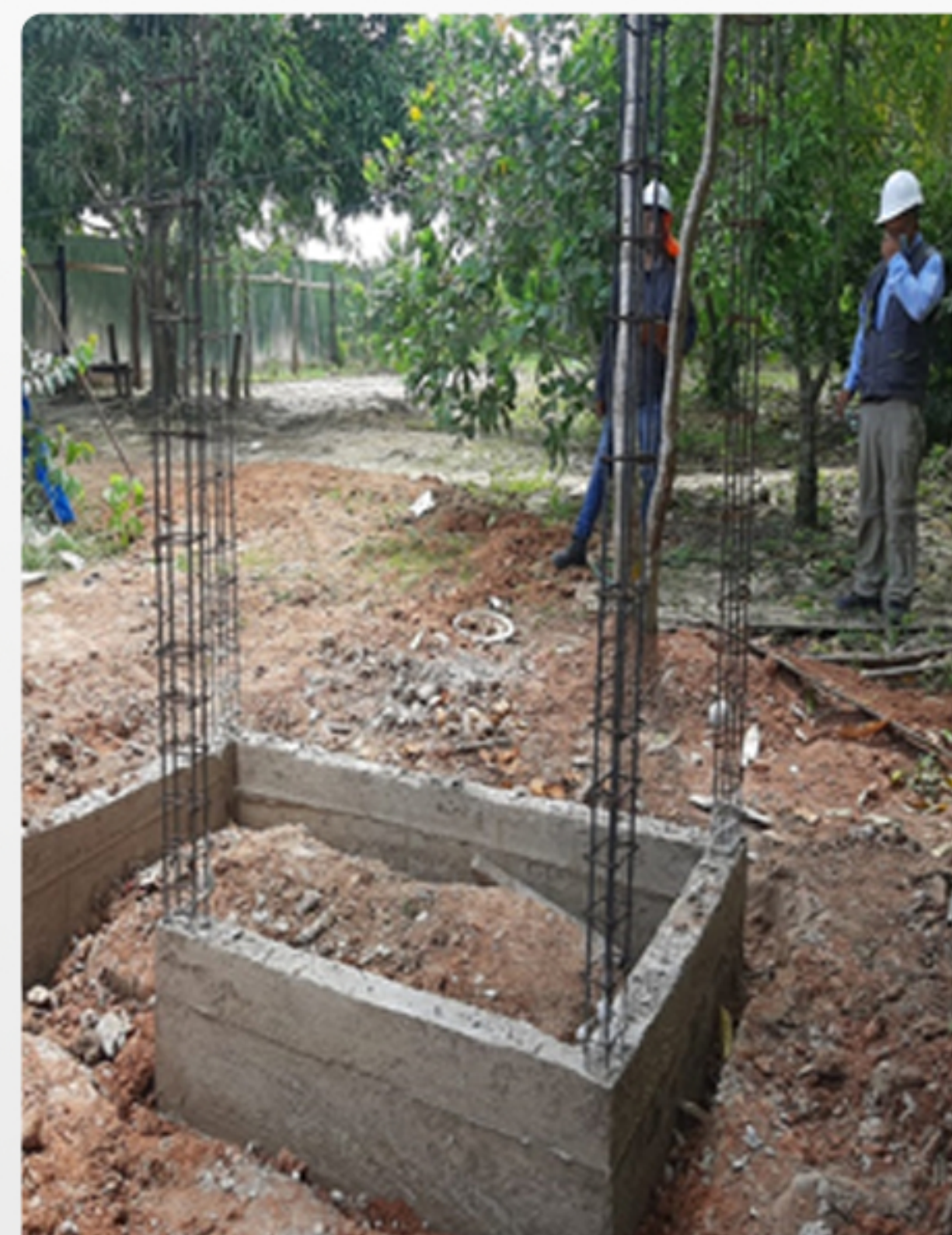
COLUMNETAS Y SOBRECIMIENTO EN UBS
