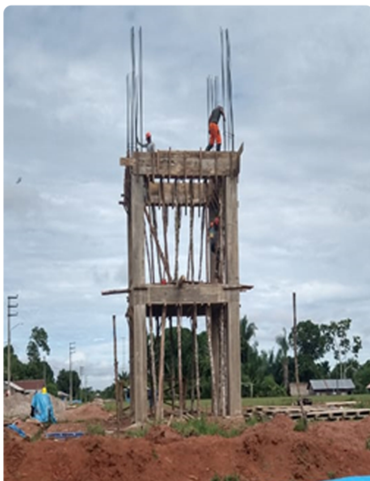
AVANCE EN LA CONSTRUCCIÓN DE RESERVORIO
