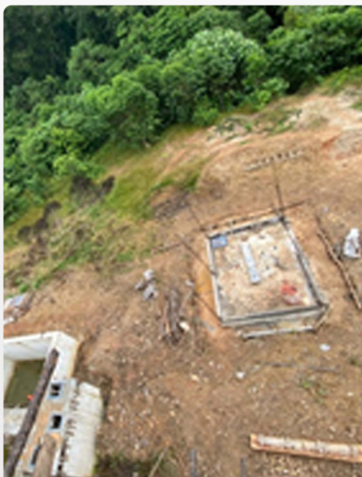
AVANCE EN CONSTRUCCIÓN CÁMARA DE LOSA DE LAVADO
