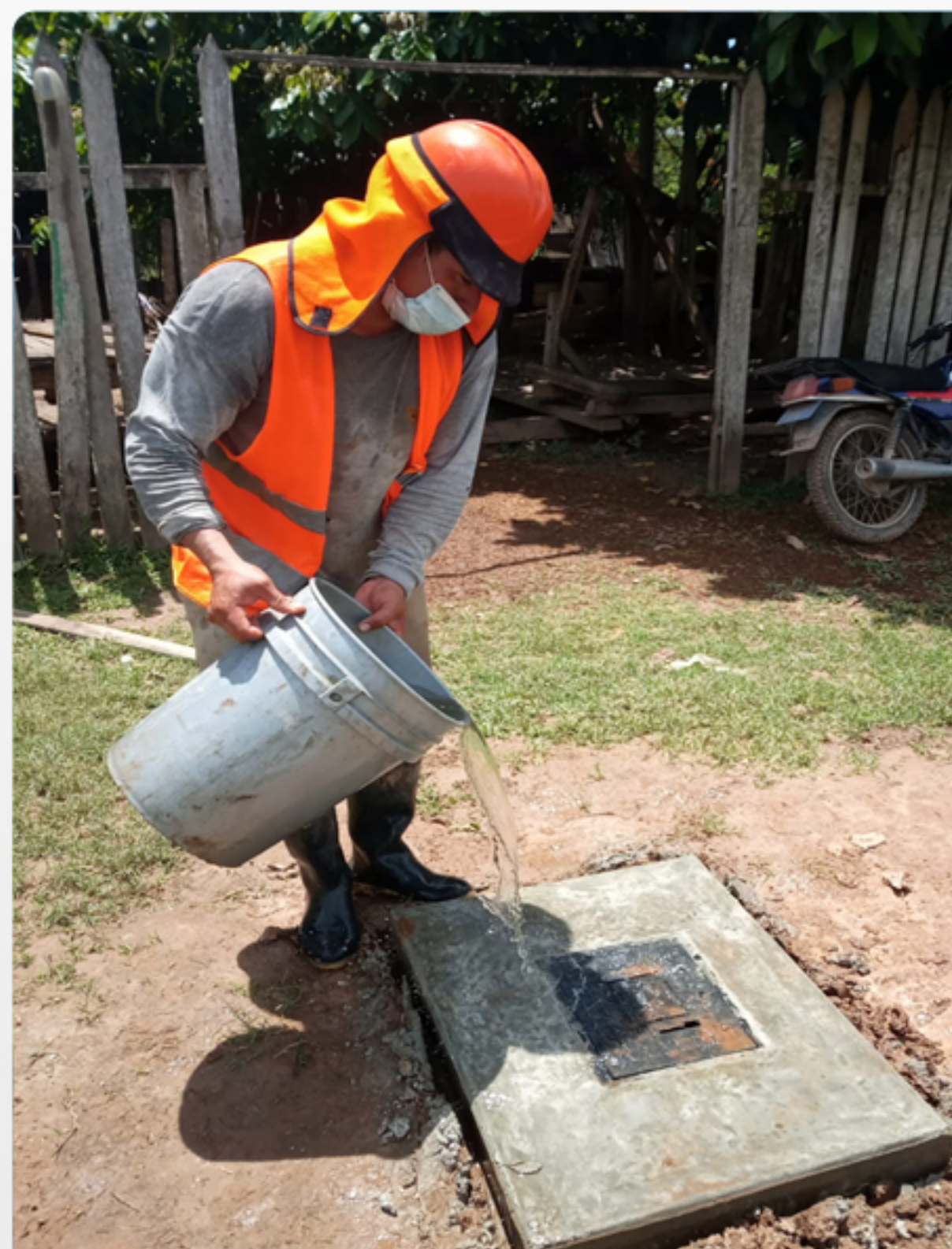
CONTROL DE LA FRAGUA EN LAS CAJAS DE REGISTRO
