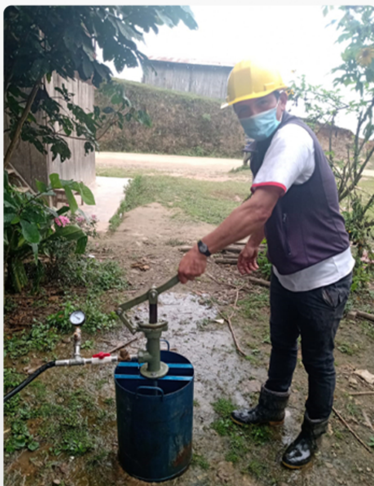
PRUEBA HIDRÁULICA DE LAS CONEXIONES DOMICILIARIAS
