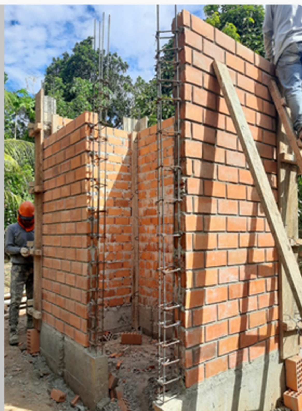
AVANCE EN LA CONSTRUCCIÓN DE UBS
