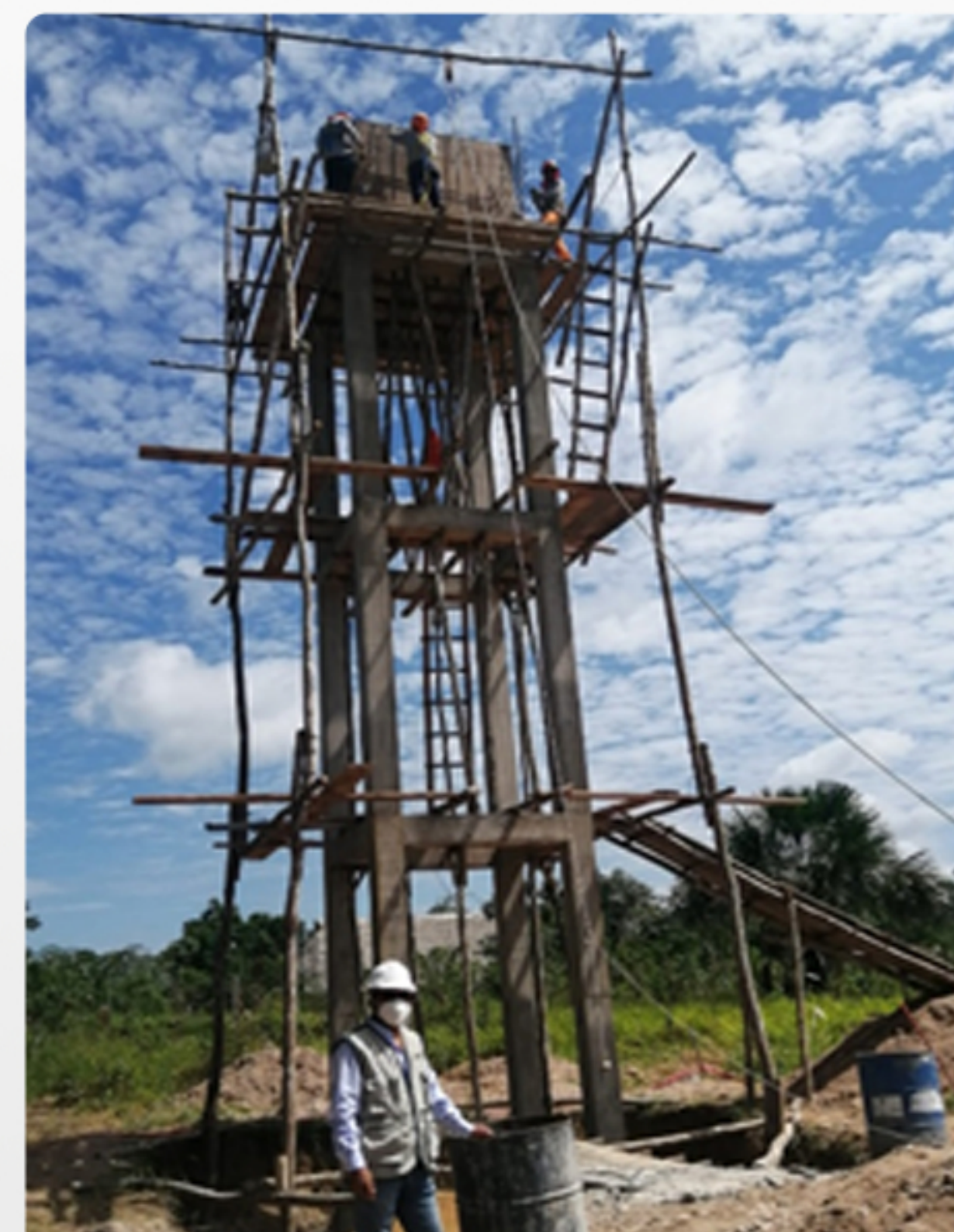
ENCOFRADO DE RESERVORIO
