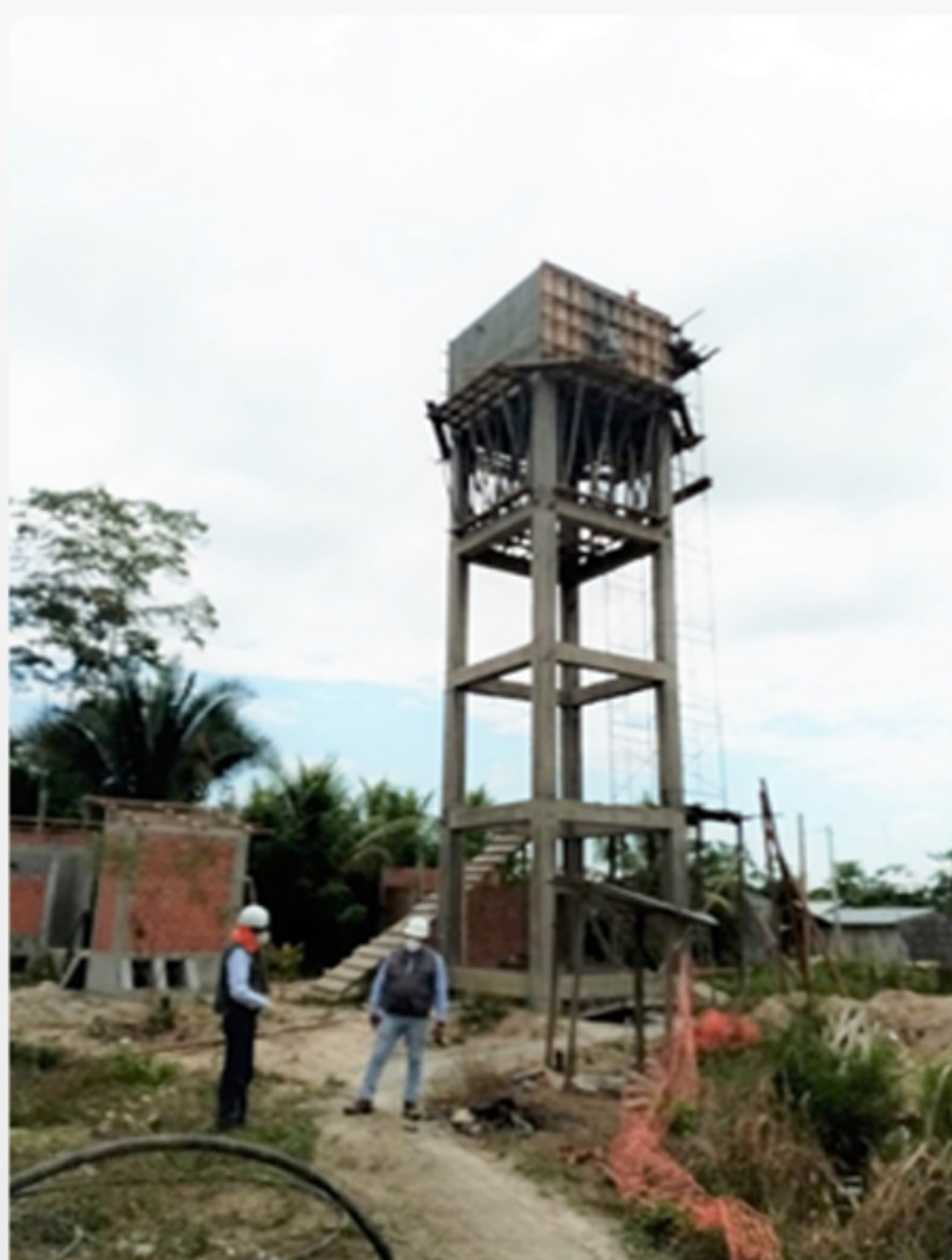
DESENCOFRADO DE TANQUE ELEVADO 22 M3
