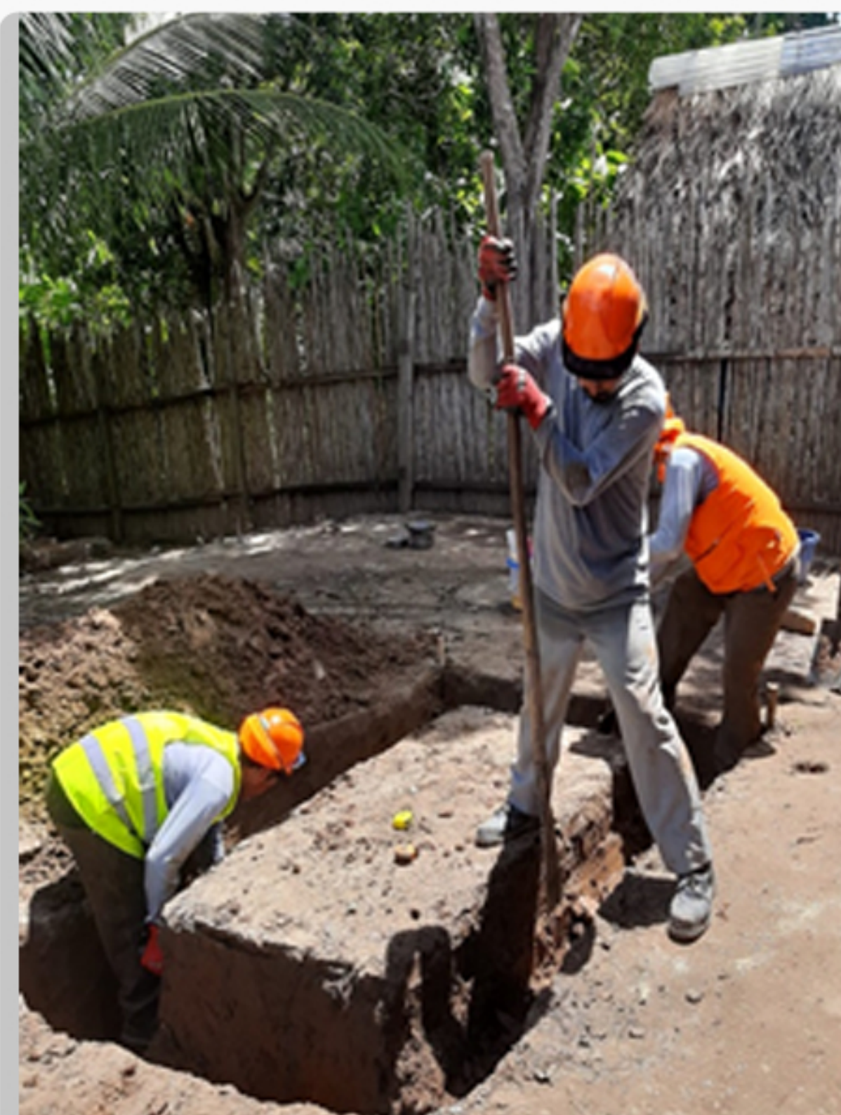
EXCAVACIÓN DE ZANJA PARA UBS
