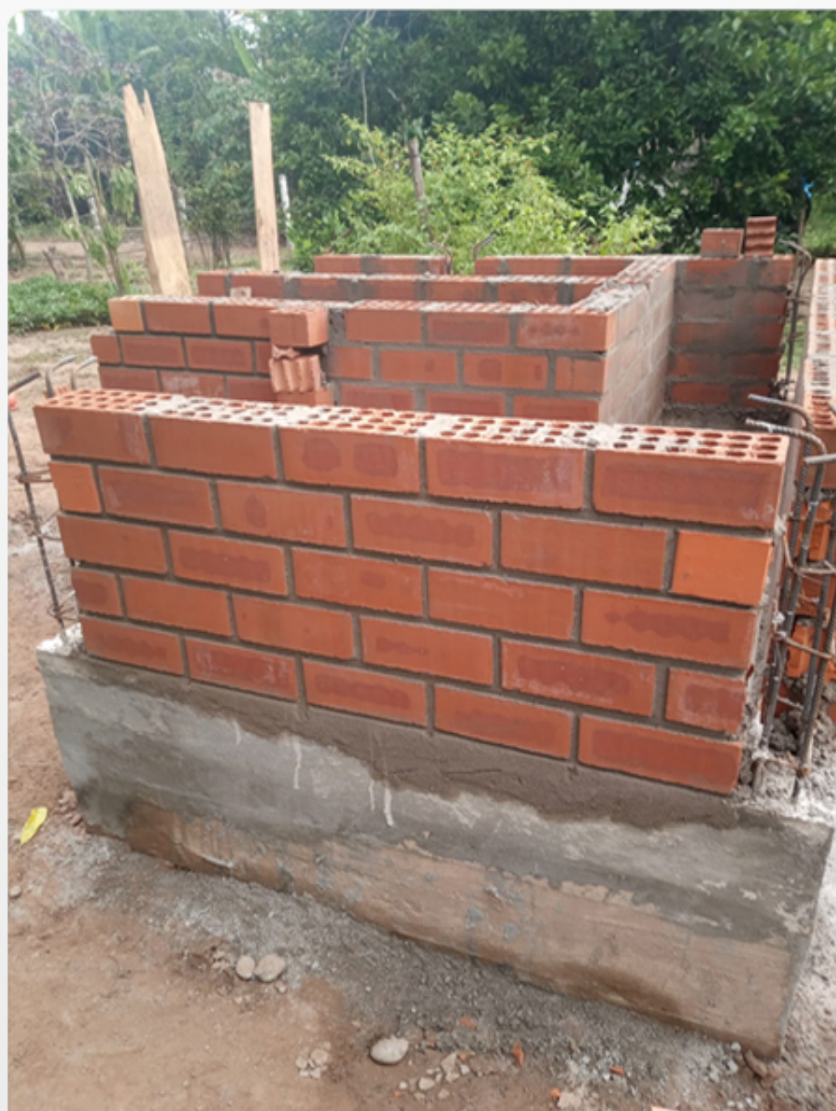
AVANCE EN LA CONSTRUCCIÓN DE UBS
