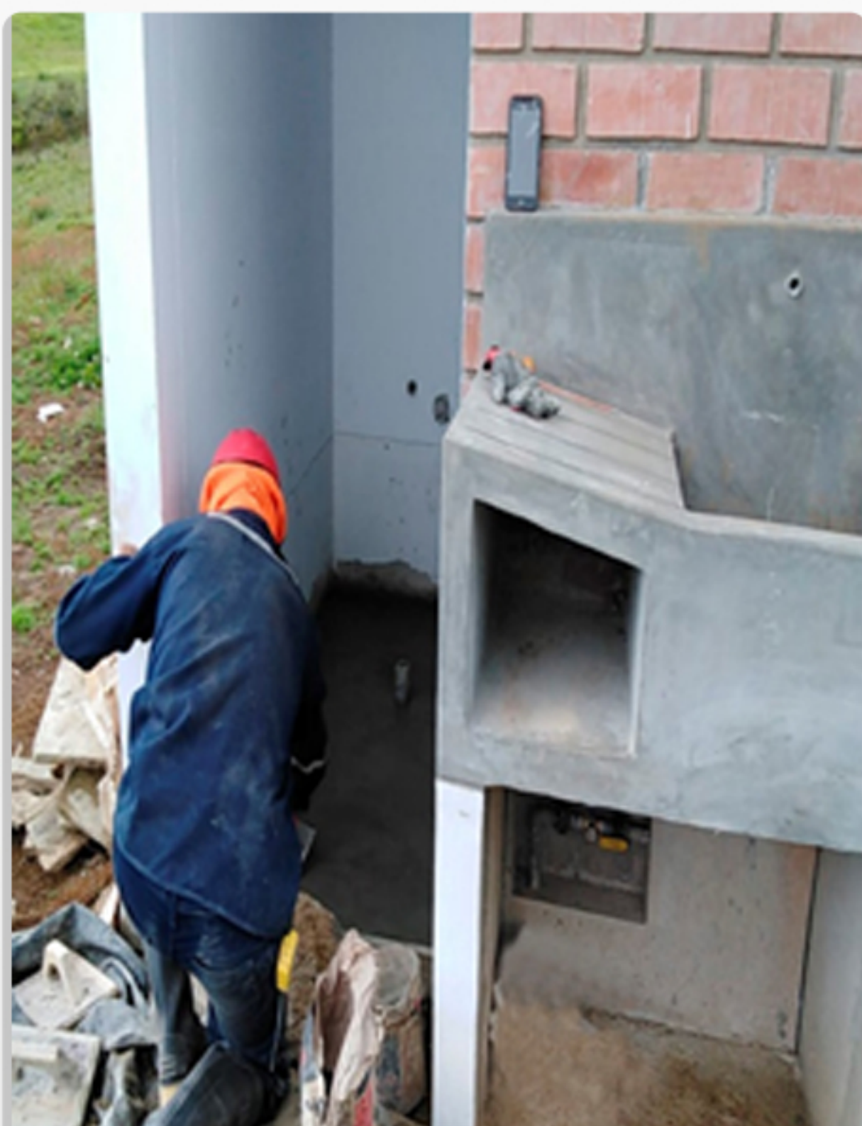
VACIADO DE PISO DE CONCRETO EN UBS
