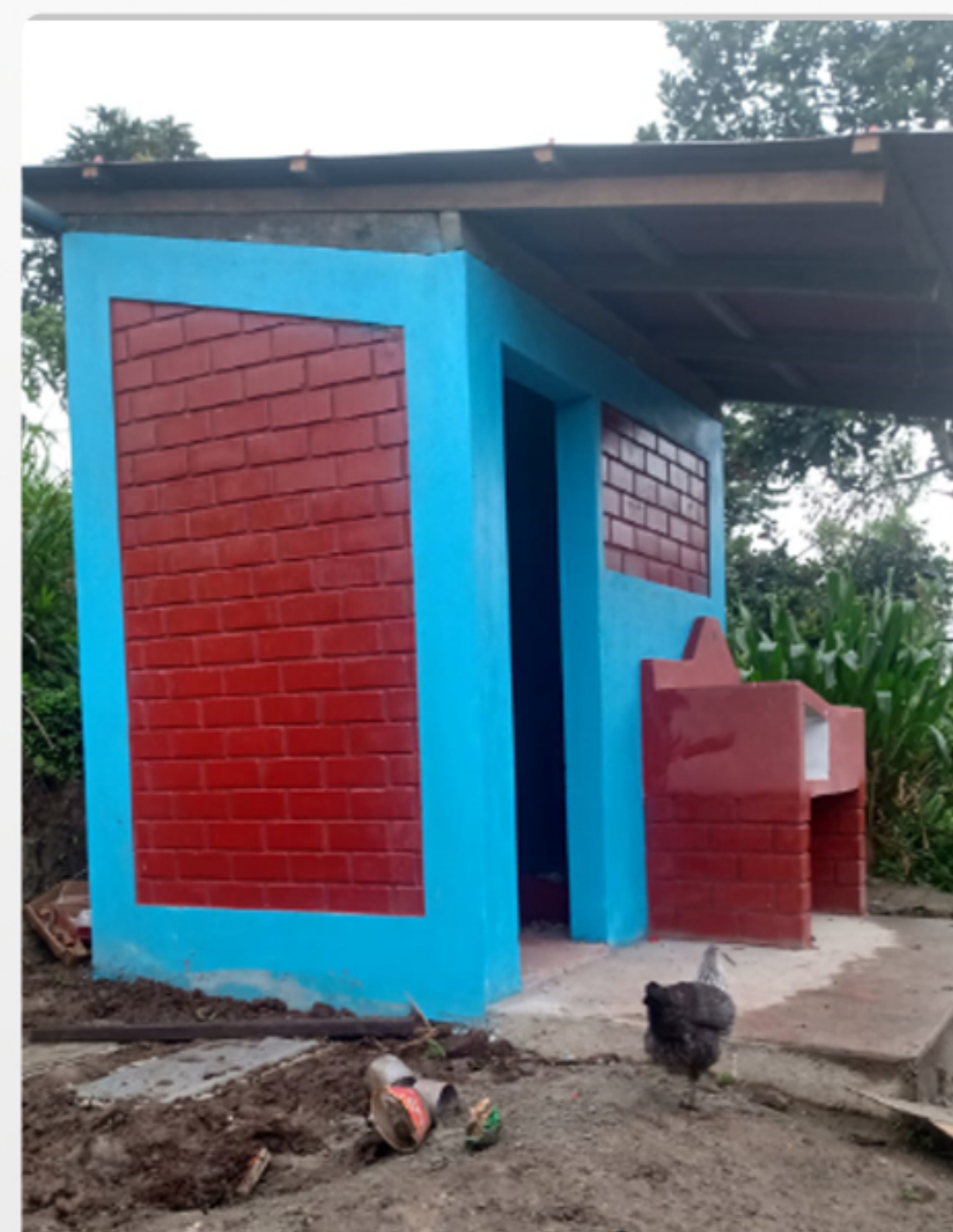
AVANCE EN ACABADOS DE UBS
