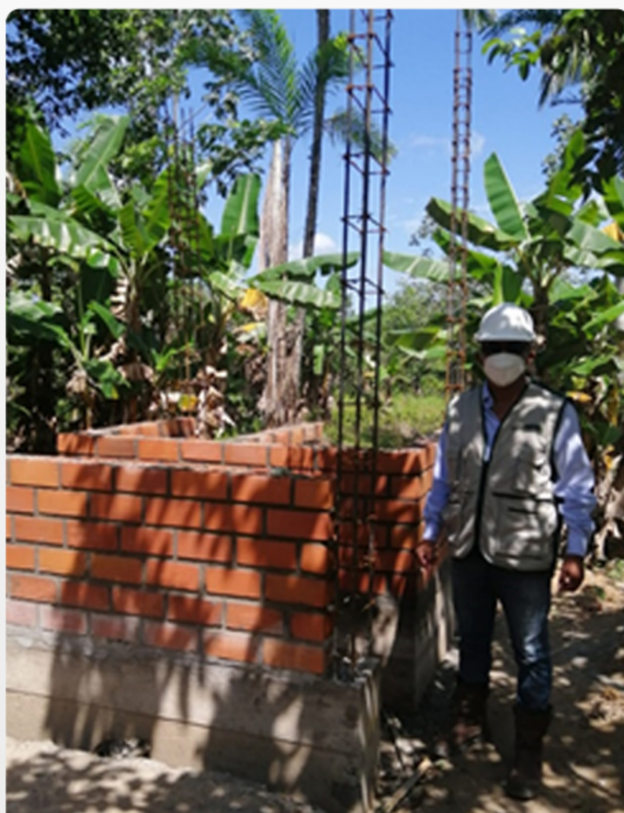
AVANCE EN LA CONSTRUCCIÓN DE UBS
